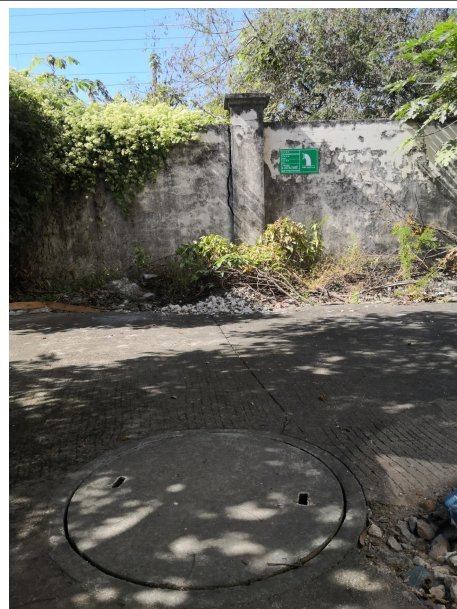
DW001 废水排放口远照
