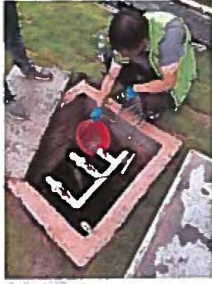
生活污水排放口
