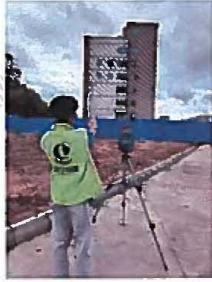
厂界下风向监控点 2#
